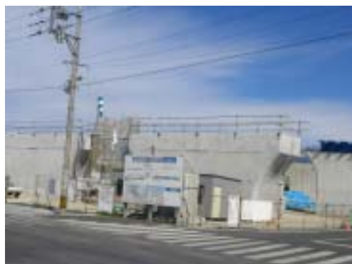
写真 28 建設中の道路
