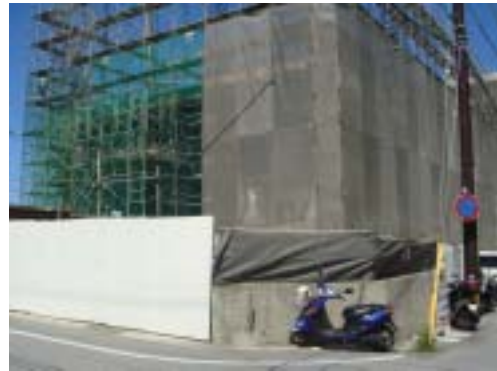
写真 10 おもろ町建築現場
